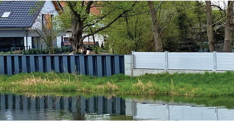
Das FloodWarden PRO-System ist die ideale Ergänzung zu dauerhaften Elementen der Hochwasserschutzinfrastruktur in urbanen Gebieten und lässt sich hervorragend mit Konstruktionen aus Vinyl- und Hybridspundwänden kombinieren.
